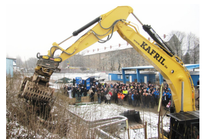
Der „Erste Spatenstich“ für den Umbau des Stadions
