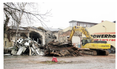
Abbruch des Straßenbahndepots
