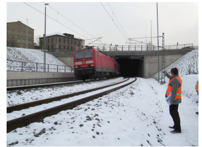
Brücke Dresdner Platz
